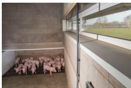
Afbeelding: Daglichttoetreding via de zijgevel
