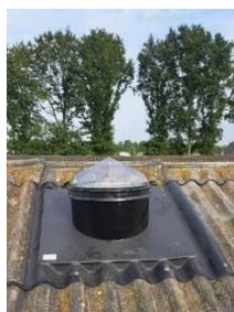
Afbeelding: Daglichttoetreding via daglichtkoker
